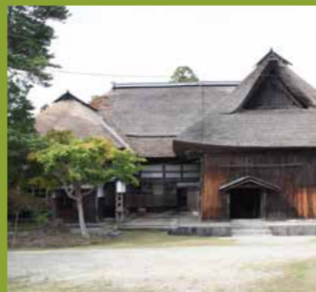
旧奈良家住宅 重要文化財 check
